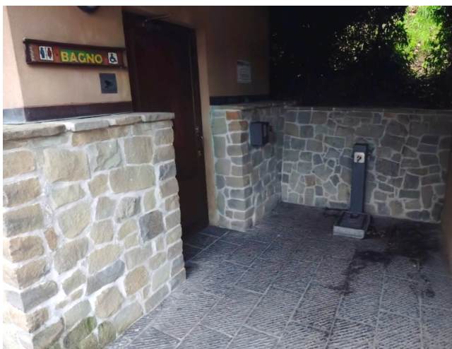
42 Ingresso esterno bagno
